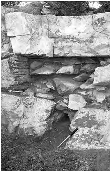
Σχ. 3. Μεγάλα Πεύκα. Τοίχος αντιστήριξης καμίνου. Στη βάση του καταλήγει το κανάλι εμφύσησης αέρα.
