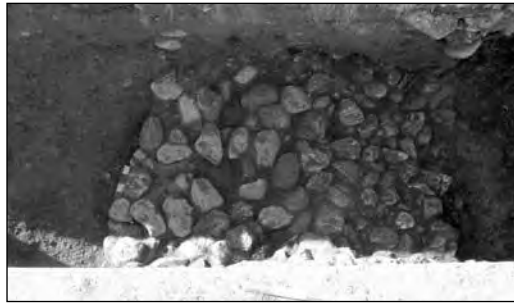
Εικ. 4. Οδός Έβρου: Λιθόστρωτο υπόστρωμα δαπέδου ΠΕΧ.
